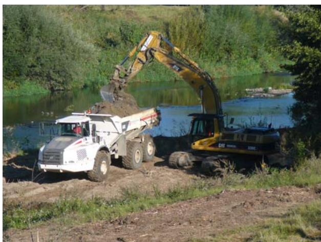
Travaux préparatoires à l'installation du batardeau © DIR Massif Central/SIR
