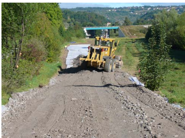
Création de la piste d'accès au chantier © DIR Massif Central/SIR
