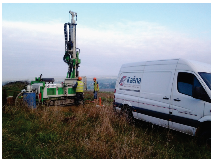
Engin de sondages géotechniques Crédits photo : KAENA
