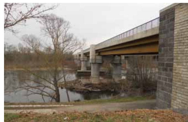
La RD67, au niveau du franchissement de l'Allier
