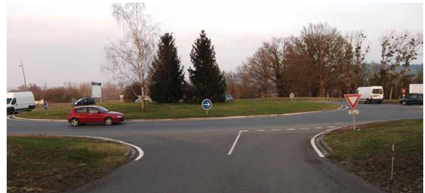
Le giratoire de la Goutte, depuis l'actuel accès des riverains
