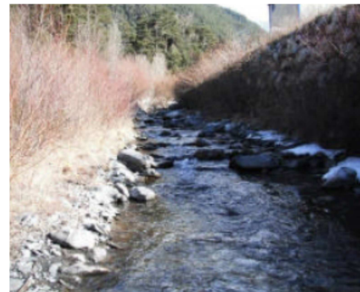
amont pont de la RD 119
