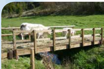
Mise en place d'une passerelle pour le bétail. © G. Motte.
