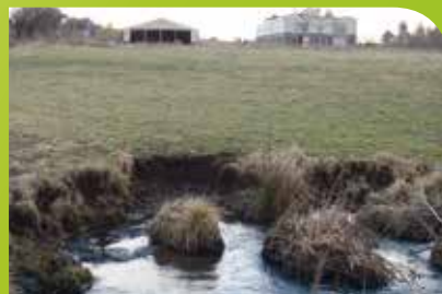
Berges érodées en l'absence de ripisylve © SMVVA A. Mathevon.
