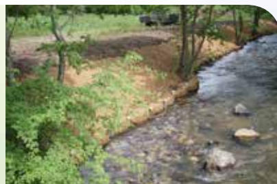
Aménagement naturel de berges en génie végétal. © G. Motte.
