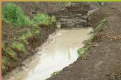
Dégradations liées à la pratique de sports mécaniques © SMBRC.
