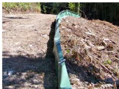
Cette clôture sera soit inclinée vers l'extérieur de la zone de chantier (pour permettre une échappatoire aux animaux depuis la zone de chantier tout en leur interdisant l'accès) soit, en cas d'impossibilité de disposer la clôture verticalement, elle présentera un bavolet vers l'extérieur de la zone de chantier pour interdire l'accès aux animaux. Les figures suivantes illustrent la géométrie de la clôture.
