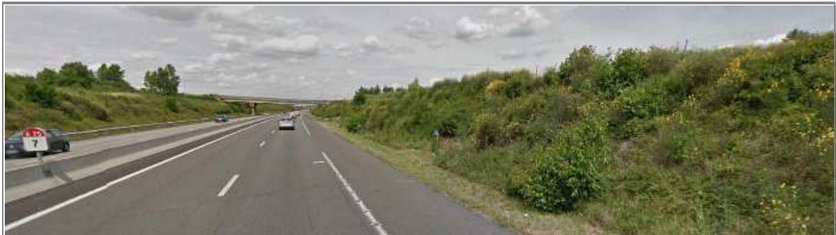
Figure 25 : En allant vers Clermont-Ferrand, avant le passage sous le pont de la RD 756, le site est masqué par le talus de l'autoroute.
