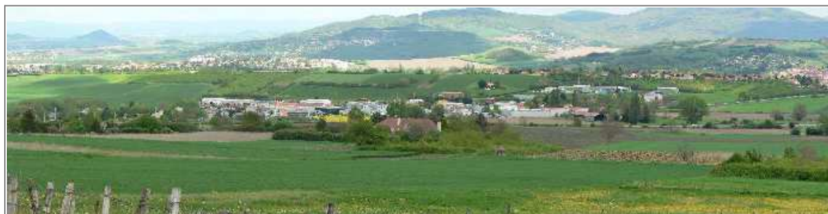
Figure 14 : Depuis la RD 756 à l'ouest du Parc d'Activités Économique de la Noviale-Gergovie, celui-ci est bien visible en raison de la situation en surplomb de cette voie, mais les vues demeurent fugitives à cause de la végétation qui masque régulièrement le parc à la vue des automobilistes.
