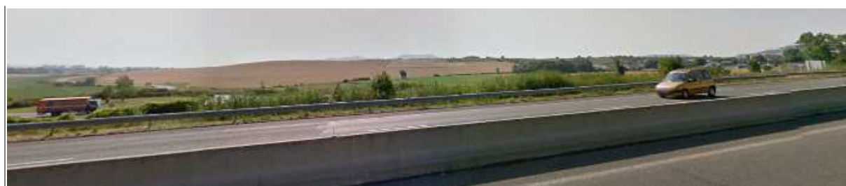
Figure 20 : En provenance du nord, le site de l'extension nord est largement visible au droit de l'A75 mais cette vision est fugitive car l'autoroute s'engage rapidement dans une section en tranchée.
