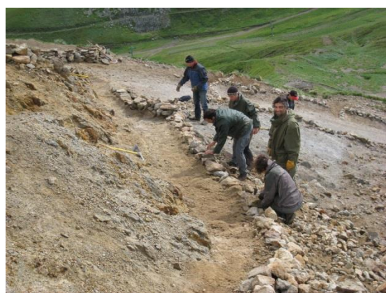
des chantiers communs
