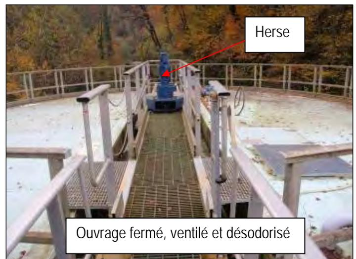
Les boues extraites du clarificateur via la recirculation sont épaissies gravitairement dans un ouvrage cylindro-cônique, hersé et raclé. L'extraction s'effectue avec une pompe d'extraction des boues recirculées vers l'épaississeur dont la capacité est de 45 m<sup>3</sup>/h.
