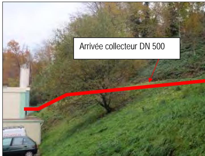
A noter que le collecteur d'aménée des effluents possède une capacité max estimée à 840 l/s (Donnée SAGEGE) soit environ 3000 m<sup>3</sup>/h ;
