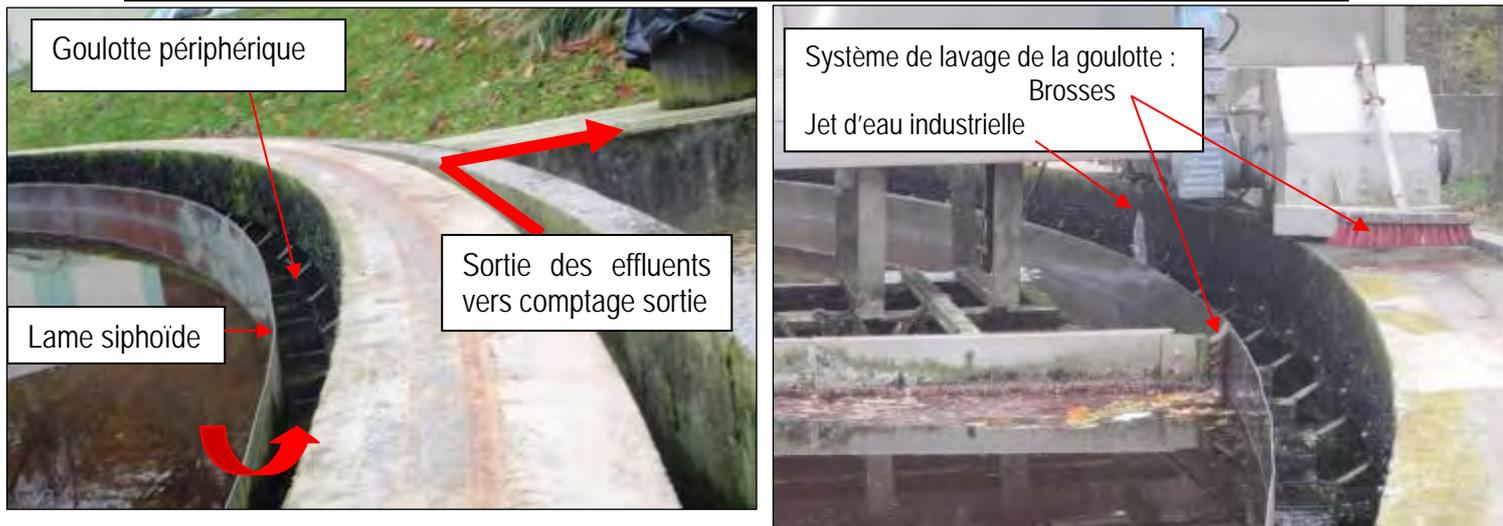
Le clarificateur est équipé d'une lame siphonide qui permet de retenir les flottants. Les flottants sont repris et mélangés aux boues décantées.
