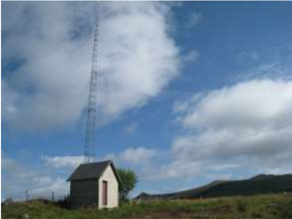
Figure 44 : antenne relais, bâtiment et ligne téléphonique du Pascher
