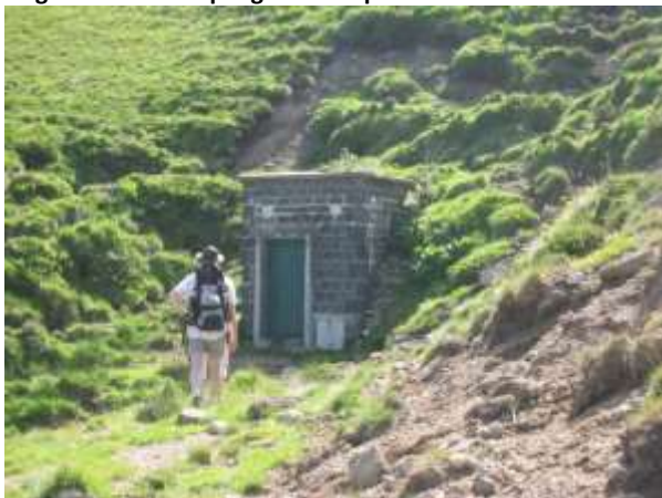
Figure 60 : le captage d'eau potable de Saint-Donat
