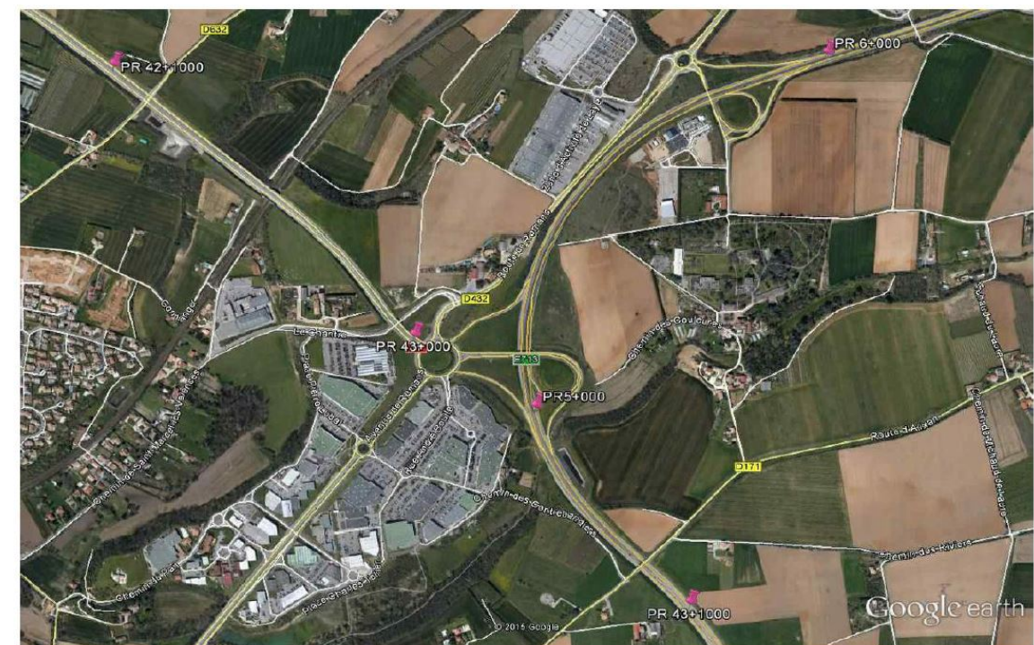
Photo 53 : Localisation des accidents ayant eu lieu entre 2011 et 2014 sur le secteur des Couleures
