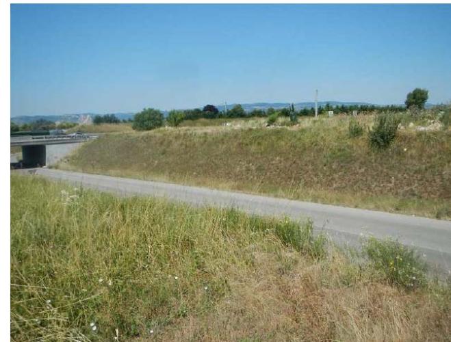
Photo 3 : Passage inférieur du chemin du Chantre (en déblais) sous la RN7 (©CEREMA - Dter CE)
