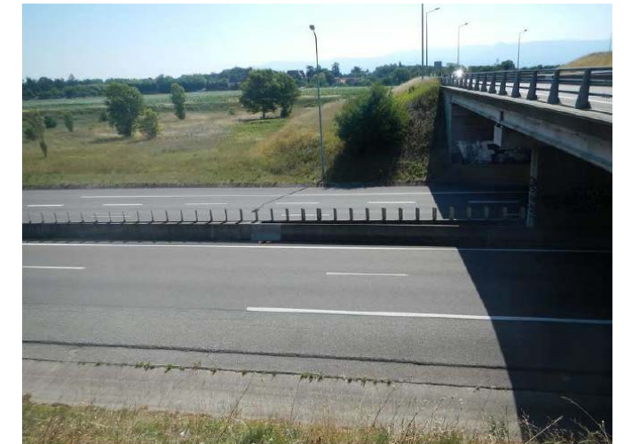
Photo 4 : Passage supérieur de la bretelle d'accès au-dessus de la RN7/RN532 (à hauteur du terrain naturel à l'Ouest et en remblai côté Est, ©CEREMA - Dter CE)
