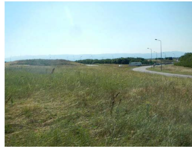
Photo 1 : Bretelle d'accès à la RN7 Sud depuis le giratoire (©CEREMA - Dter CE)
