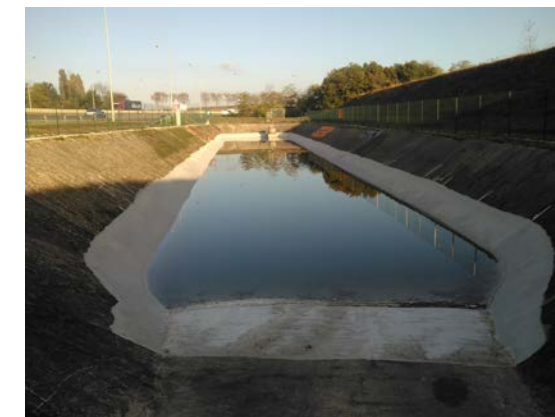
Photo 5 : Bassin de rétention à l'Est de la RN7 (Sens A7/A49 – PR 43+ 500)
