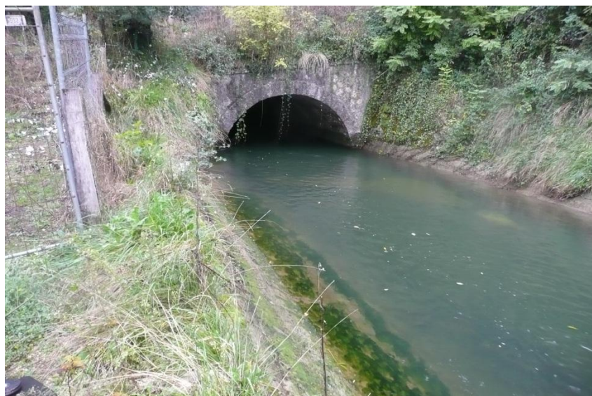
Photo 2 : Entrée du tunnel de Barmier
