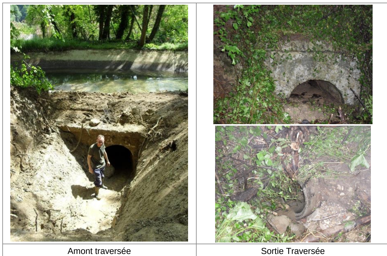
Photo 3 : Dalot sous le canal de la Bourne en amont du tunnel de Barmier
