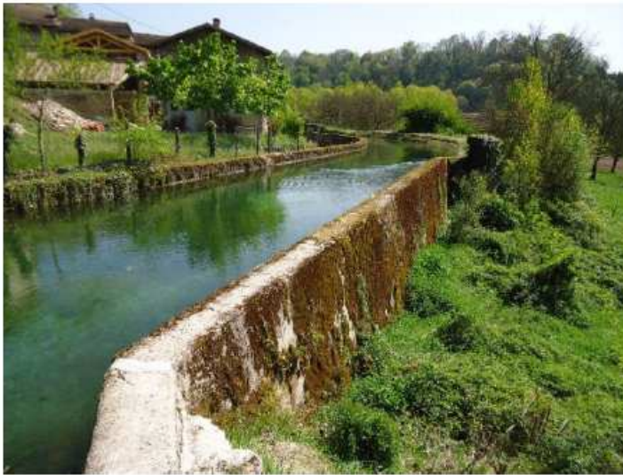
Photo 8 : Mur de confortement existant en amont du tunnel de Servant
