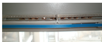
Lumières non calibrées dans les menuiseries
