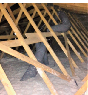
Mauvaise mise en œuvre des réseaux de gaines aéraliques
