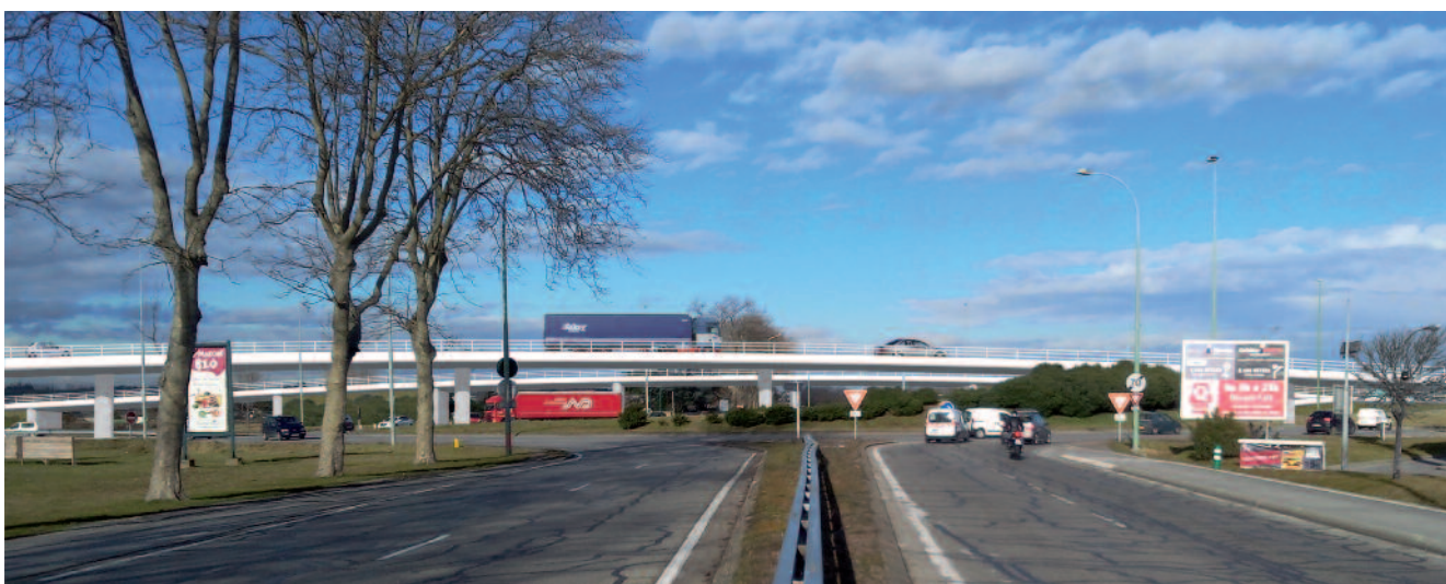
Vue depuis l'avenue de Romans : le pont très long permet de garder des ouvertures
