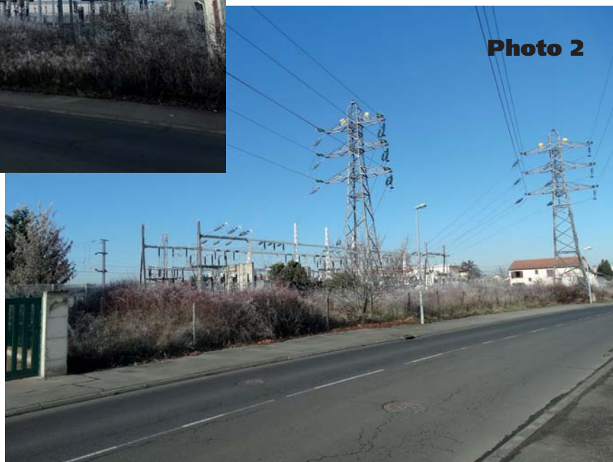
Vues sur la zone d'extension du poste de RIOM
