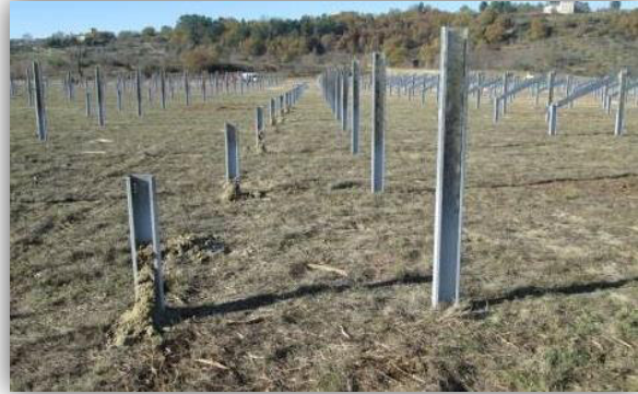
Battage de pieux
