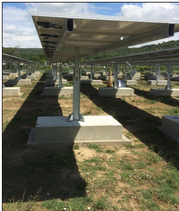
Plots béton et fixation des structures
