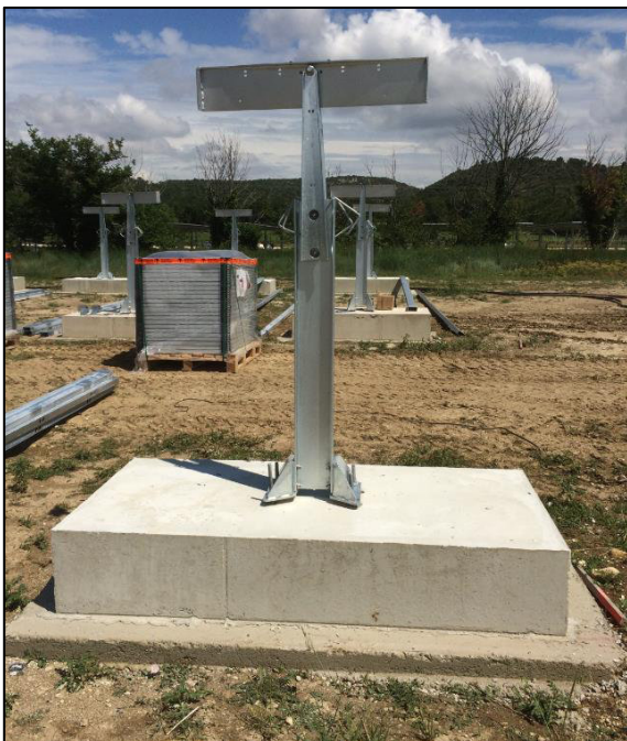
Plots béton et fixation des structures
