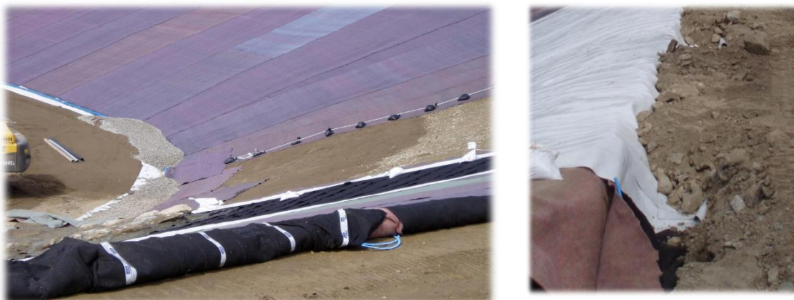
Géomembrane PVC calée dans la tranchée d'ancrage ▲
