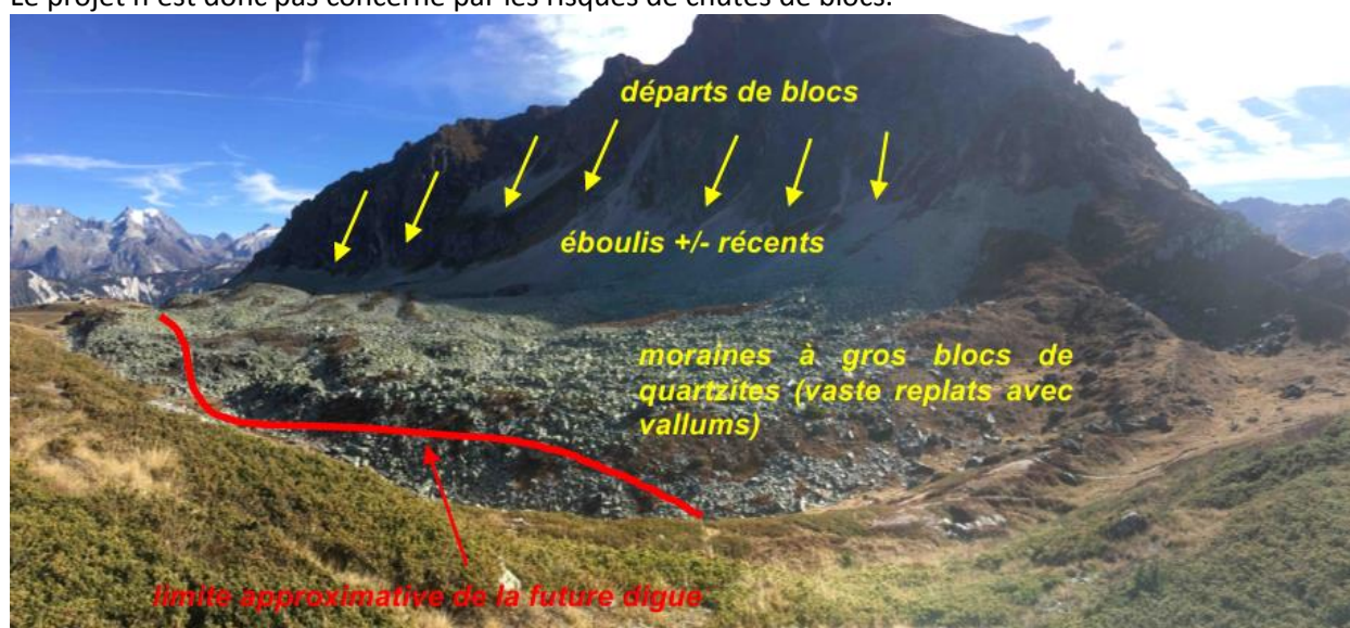
Figure 18 : les risques d'éboulis
