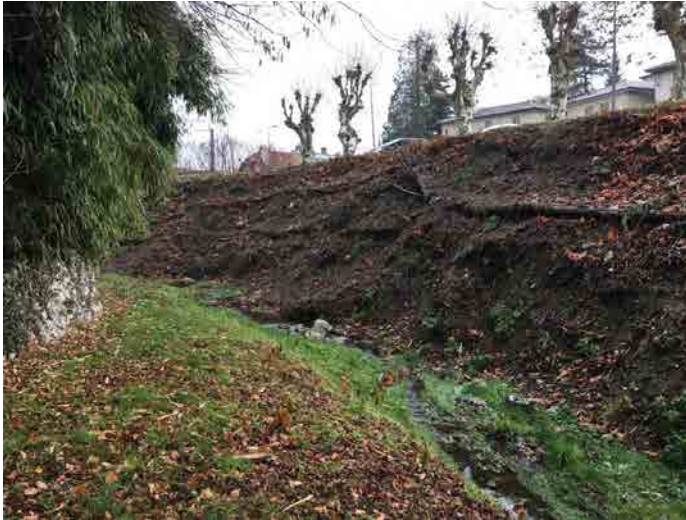
Traverses horizontales en bois placées uniquement pour permettre l'accessibilité au personnel chargé de tailler la renouée du japon tapissant la berge.
