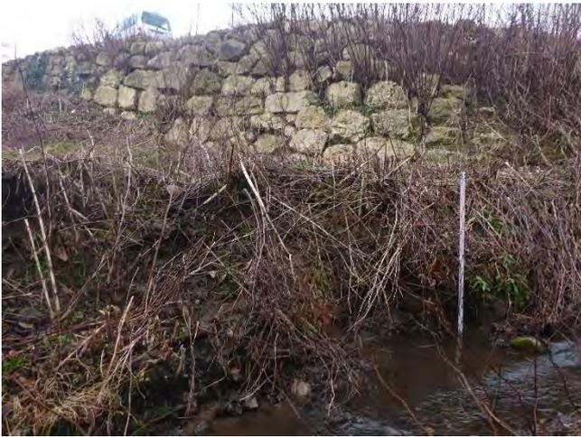
*Remblai rive droite protégé par des enrochements*
