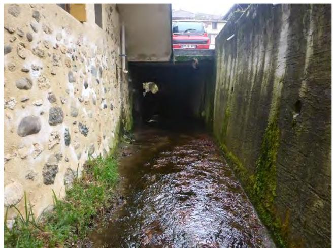
*Sortie du passage couvert en aval du pont de la RD518 (rejet direct d'eaux usées en rive droite)*
