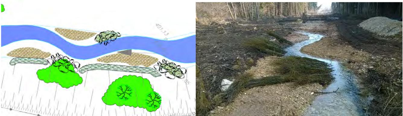
Figure 25 : Protection de berge mixte et décalage du lit (pris sur PT27) :
