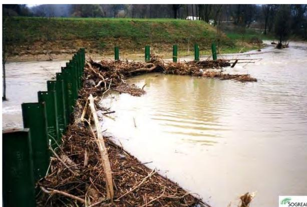
Figure 70 : Photographie d'un piège à flottant en extrados (Source : SOGREAH)
