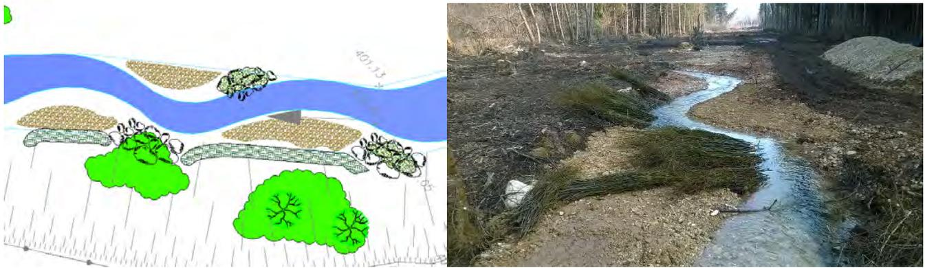
Figure 30 : Protection de berge mixte et décalage du lit (pris sur PT24) :
