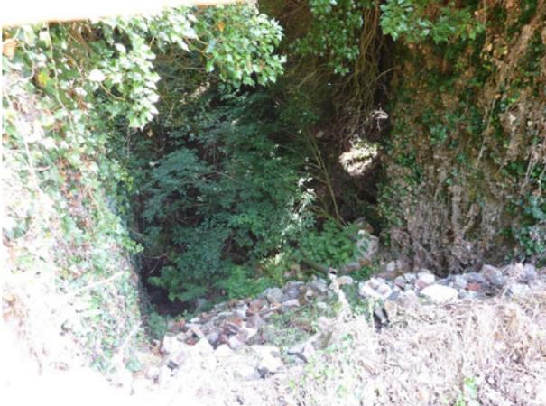
Le puits Sainte-Barbe est situé dans un bâtiment en ruine. La tête du puits d'un diamètre d'environ 5 mètres est en partie comblée de matériaux divers.
