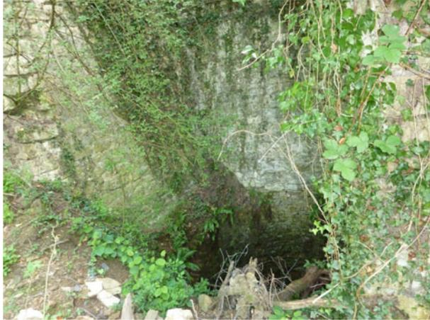
Le puits Pochin est situé dans un ancien carreau, au pied d'un talus. L'entrée du puits a un diamètre d'environ 4 m délimité par des murs sur 3 faces.
