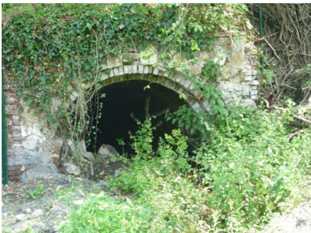
L'ouvrage MG25 est une galerie d'exhaure d'un peu moins d'un mètre de hauteur de voûte et d'environ 150 m de long. L'extrémité de la galerie rejoint le Puits Mony.
