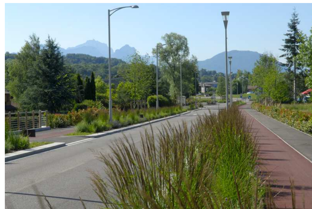
Figure 7 : Exemple d'aménagement - traversée d'Allonzier-la-Caille sur la RD1201
