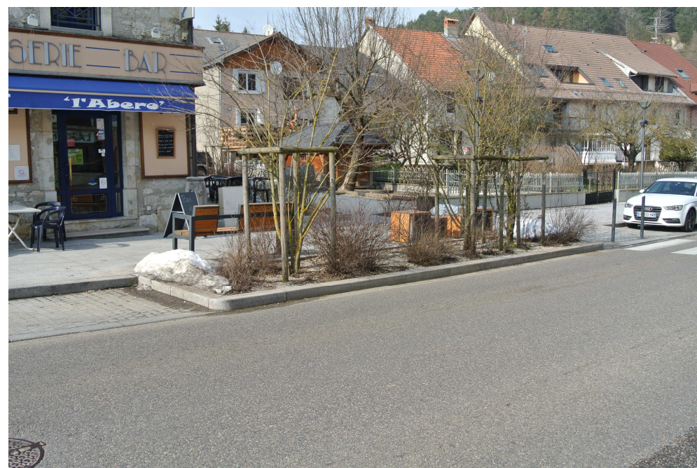
Figure 5 : Exemple d'aménagement - Traversée de Cruseilles sur la RD1201
