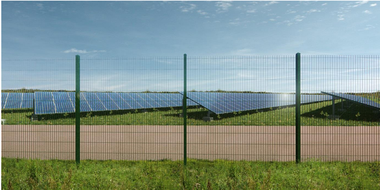
Vue « G » : Point de vue direct sur le parc
