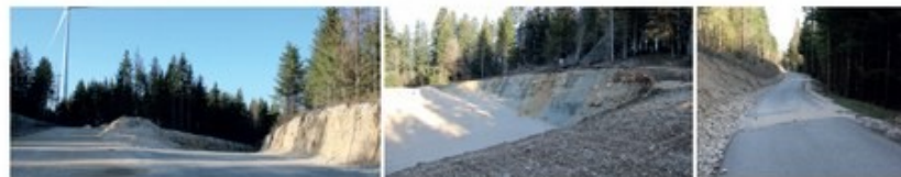
Éviter les décaissements violents lors de l'aménagement de pistes
