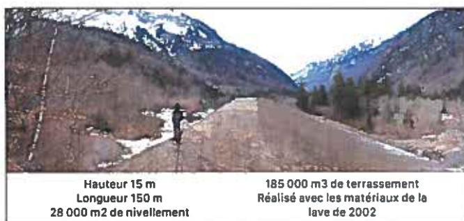
Merlon freineur en aval sur le Nant des Pères ralentissant et stoppant les aléas avant la prairie de Plan du Lac, avril 2015.
