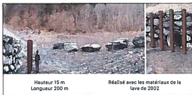
Merlon freineur et piège à matériaux amont (300 000 m3 en amont) aménagé par l'ONF-RTM, avril 2015.
